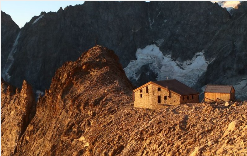
L'ancien et le nouveau bâtiment du refuge Adèle Planchard (Cyril Coursier - PNE)
