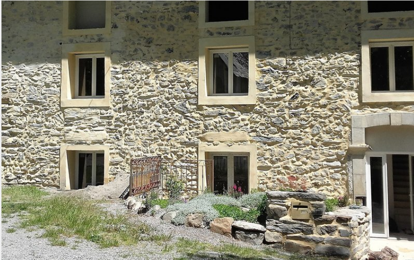
Crédit photo : Chambre d'hôtes du Villaret (Chambre d'hôtes du Villaret)
