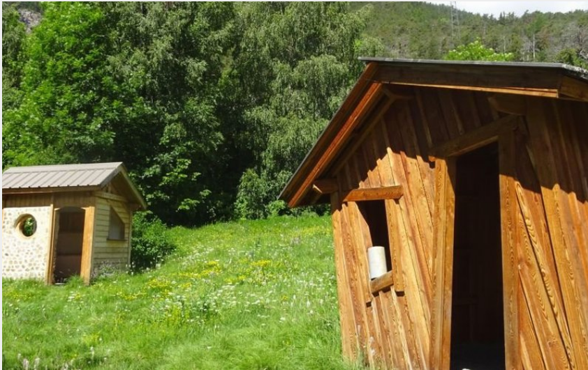
Cabanes éco-construites (Office de tourisme Pays des Écrins)
